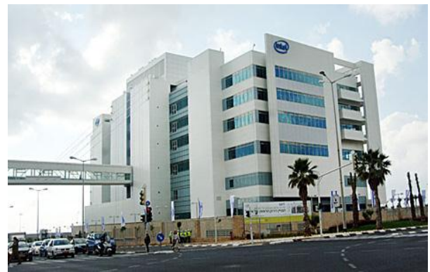
Instalaciones de Intel en Haifa, Israel. (4)
