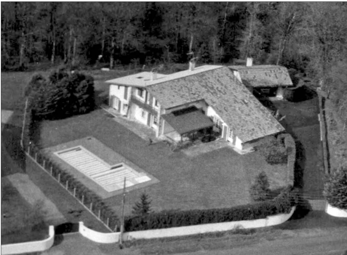
Fotografía aérea del caserío “ Txantxangorria ”, realizada por un Mirage de “ l’Armée de l’Air ”.
